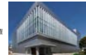
オープンイノベーション拠点として稼働を始めた新研究開発棟
