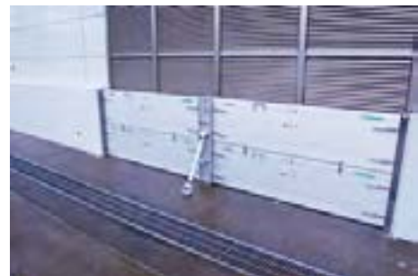
浸水リスクの低減に向けて建物入口へ止水版を設置（相模事業所）
