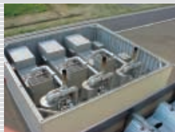
▲コージェネレーションシステムを導入し、CO 2 排出量に対するエネルギー効率の改善に努めています。
