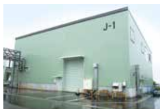
郡山工場の新純水棟
