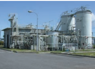
メタン発酵排水処理施設
