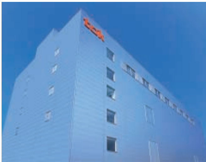
▲新研究開発棟（鉄骨造6階建、延べ床面積約5,900m 2 ）
