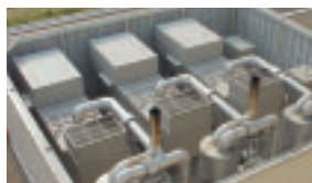
コージェネレーション 自家発電システム（郡山工場）
