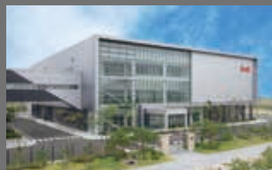
④ TOK先端材料社 本社/仁川工場
