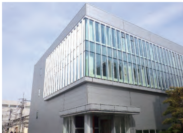
オープンイノベーション施設となる同・新B-6棟
