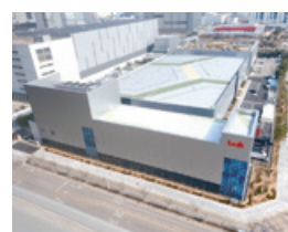
新検査棟(韓国・仁川広域市)
