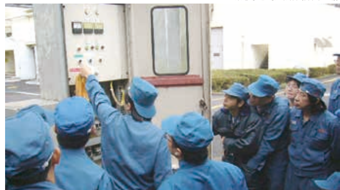
緊急事態対応訓練(御殿場工場)
