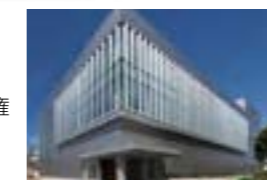
オープンイノベーション拠点として稼働を始めた新研究開発棟
