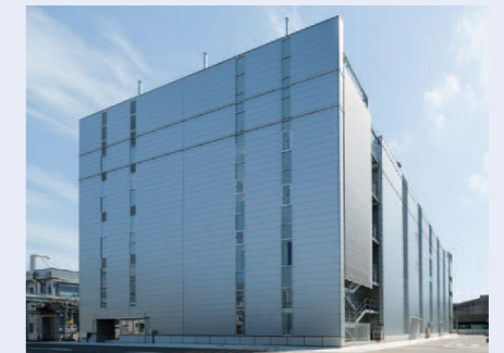
危険物対応のスーパークリーンルームをコアに最先端領域での開発が進む相模事業所「新C-1棟」
