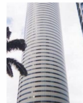
シンガポール駐在員事務所が入居しているTemasek Tower
