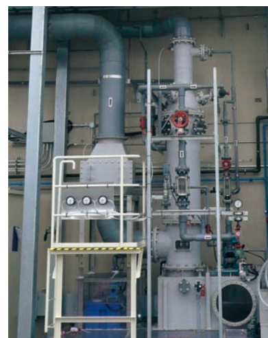
排ガス処理装置（相模事業所）
